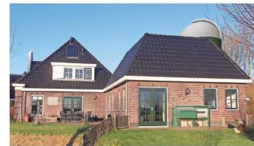
Het observatorium van Nicolàs de Hilster staat op de fundering
